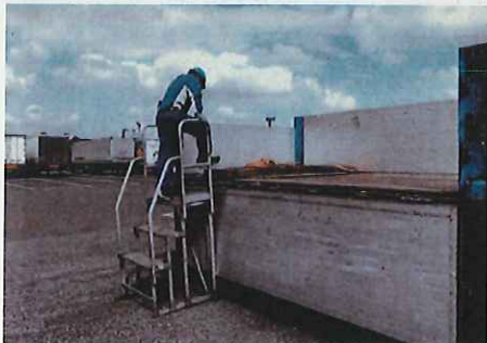
墜落・転落防止:昇降台の導入
