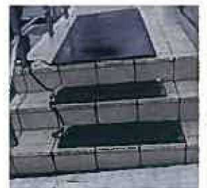
<ヒートマットの設置例>
