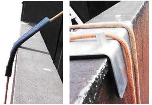
切断防止措置の例 (置き型養生) ▲
