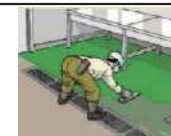
水場における防滑性能の高い床材等の導入
