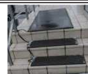
従業員通路への凍結防止装置の導入
