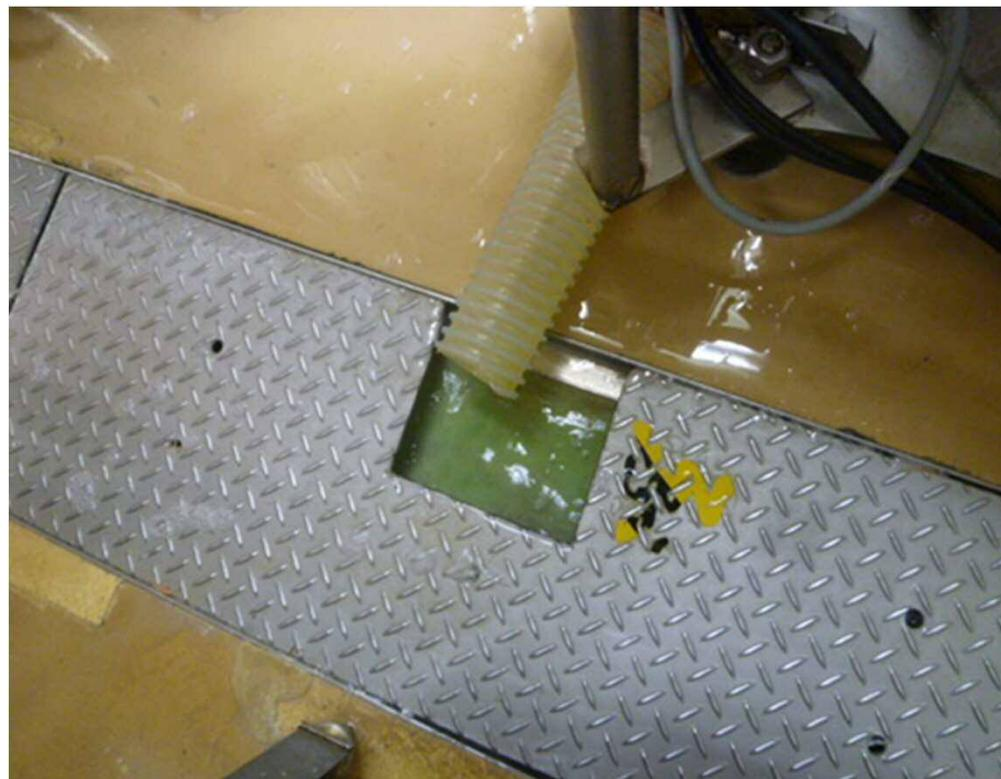
④ 作業シンクからの排水は排水パイプにて排水溝に流すようにしています。
