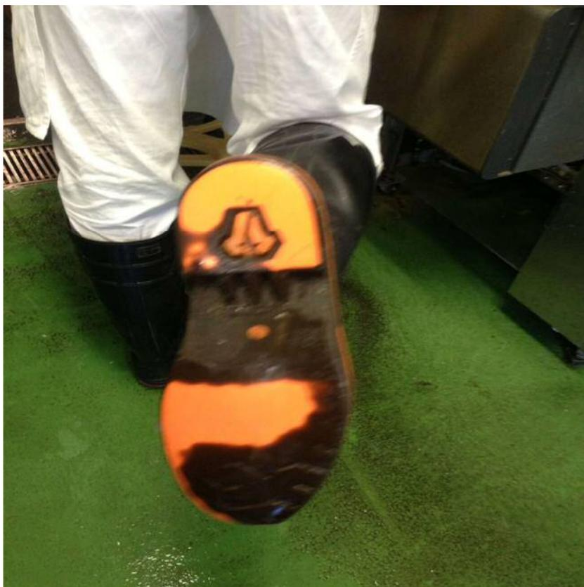
靴底の摩耗を点検していない事業場が多く、転倒災害の原因となっている。
